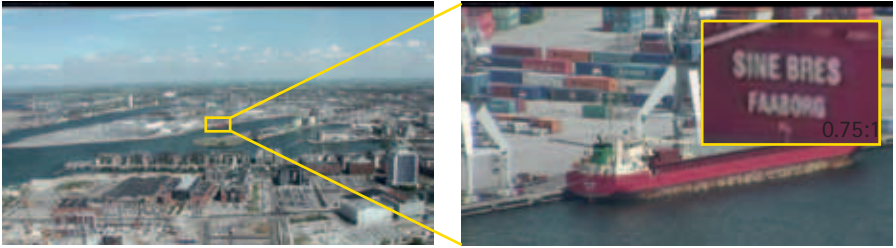
Figura 2.4i A la izquierda, vista panorámica y a la derecha, vista ampliada con un factor de zoom \times 20 y una domo PTZ HDTV 1080p, que permite la lectura del texto situado en un barco de carga a una distancia de 1,6 km (1 milla) de la cámara.
